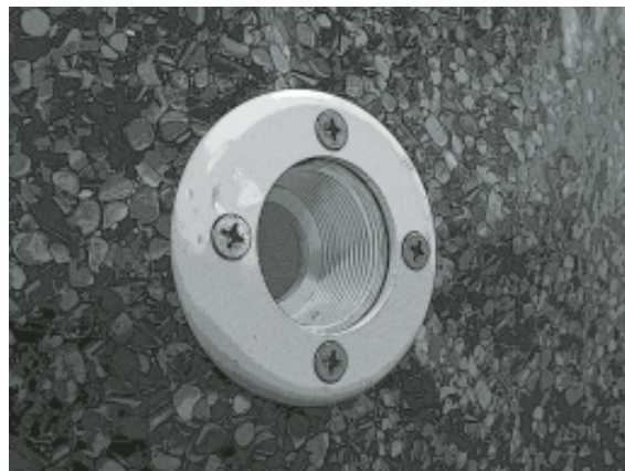
Couvre-plaque du retour d'eau installé
